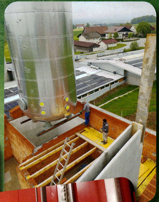
Impressionen aus der Bauphase...
