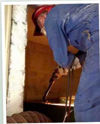
Zerschneiden des alten Öltanks
