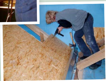
Montage des Lagerraums
